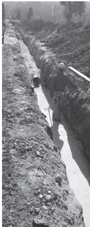
Gradnja vodovoda SORIKO poteka po pričakovani dinamiki.
